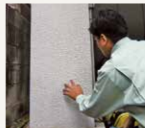
外壁は、例えば触ったら白い粉がつくような現象のチョーキングやひび割れが起きていないかを確認する
