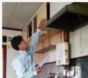
天井からの漏水の形跡がないかチェック。漏水があった場合、建物の給排水管の腐食や劣化など、設備に原因があるかも
